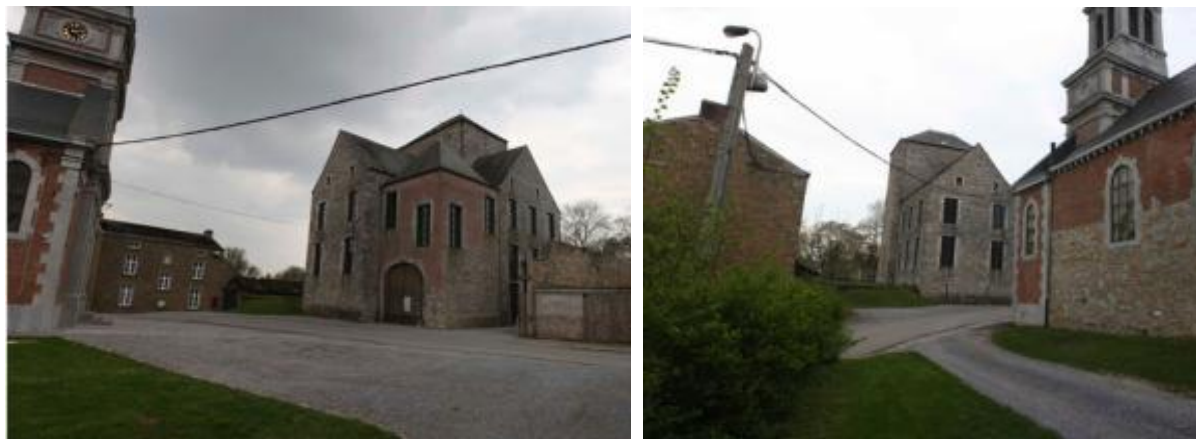
Vues depuis la rue du Perron
